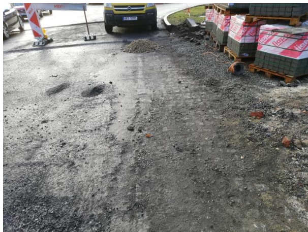
Kamenné kostky po odfrézování asfaltu.
